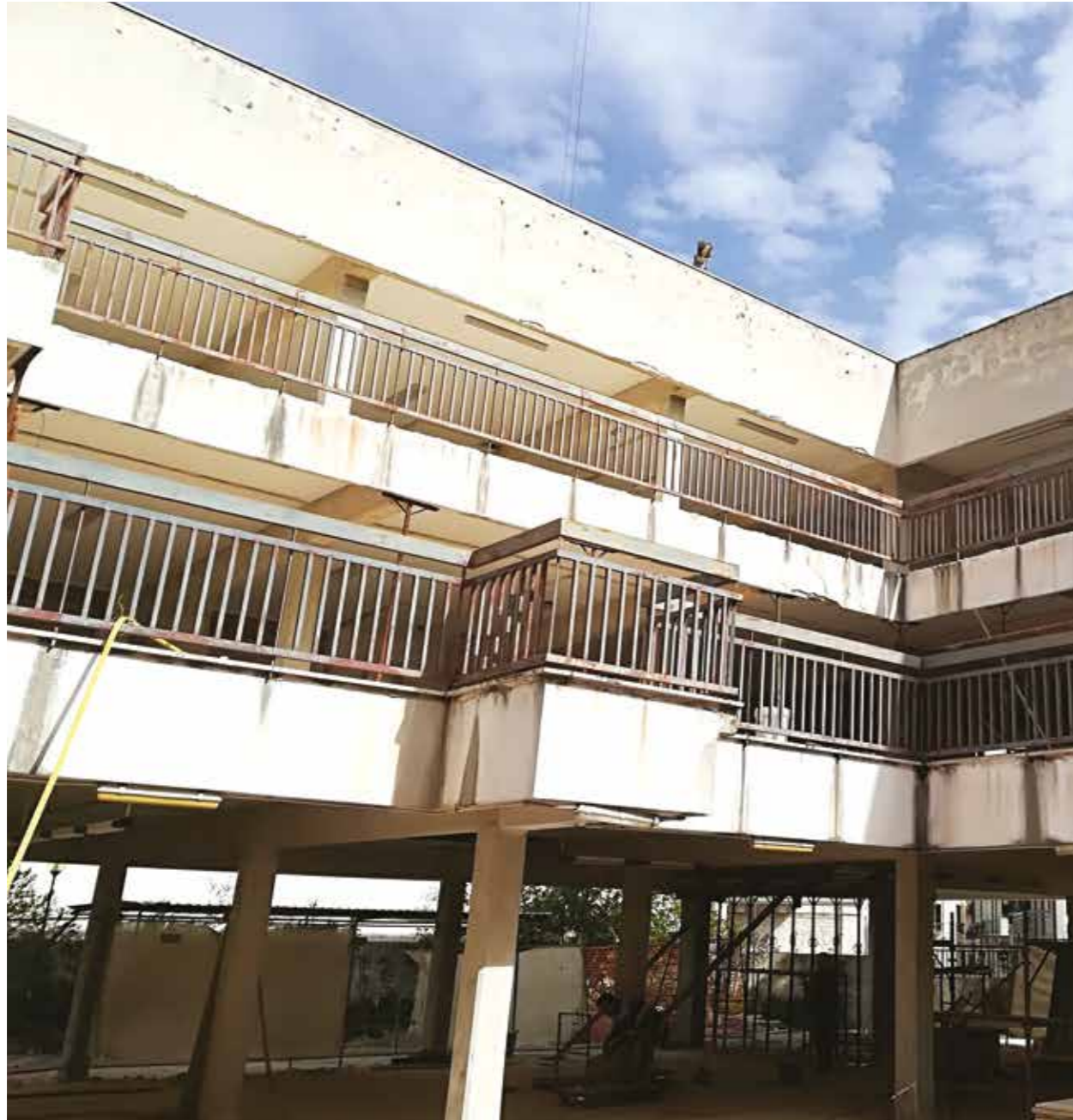
Rehabilitación sísmica de residencia geriátrica. Municipio de Giovinazzo (BA), Italia
