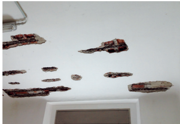
Il fenomeno dello sfondellamento cresce e si evolve nel tempo in conseguenza a diversi fattori, con necessità di intervento tempestivo per la messa in sicurezza dei luoghi .
