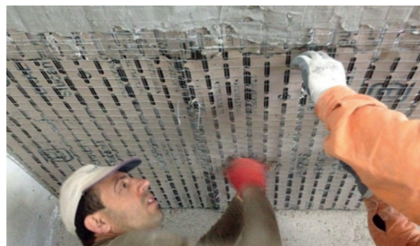
2) Posizionamento a soffitto del pannello Stucanet.
