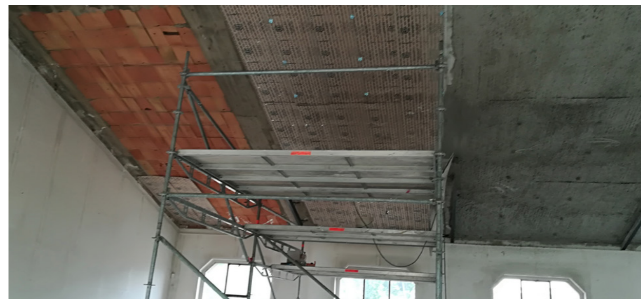
Sistema X Plaster in fase di applicazione.
