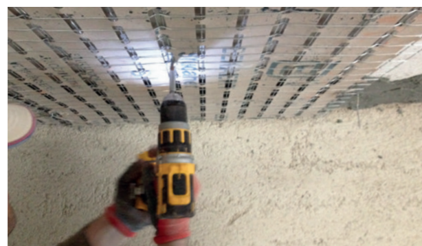
5) Avvitamento del tassello Stucanet per il sicuro fissaggio del pannello Stucanet al supporto.
