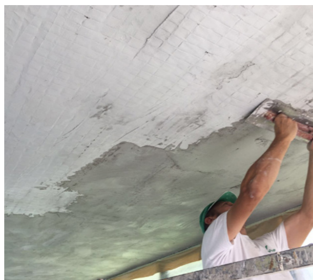
Sistema X Plaster: formazione secondo strato intonaco Plasterwall.
