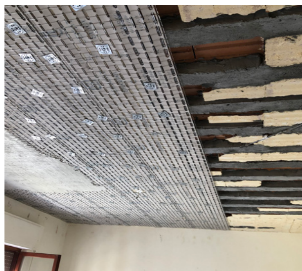
Sistema X Plaster: messa in opera pannello Stucanet.
