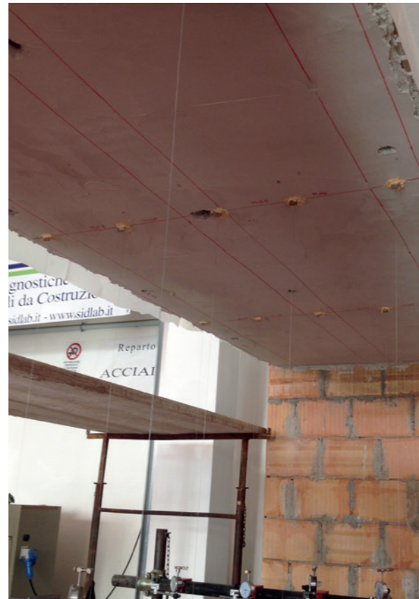
Preparazione del solaio alla prova di carico presso il laboratorio SidLab.
