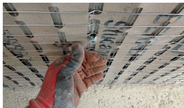
4) Posizionamento del tassello Stucanet.
