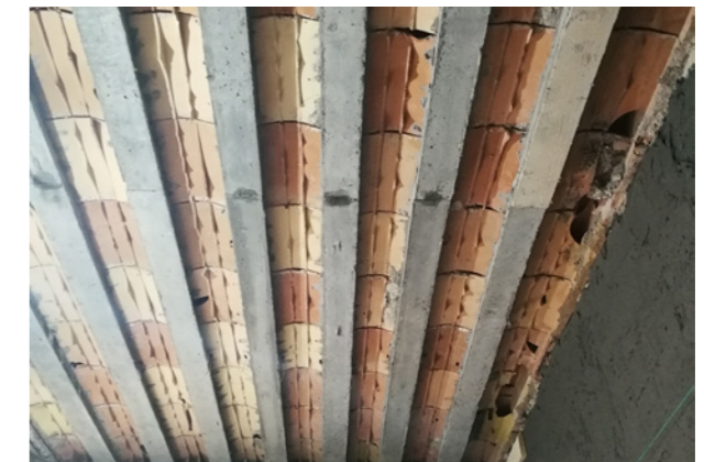
La seconda fase prevede la ricostruzione geometrica del travetto con la malta da ripristino strutturale MX Gold R4 .
