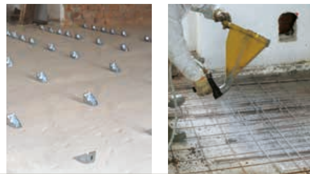
APPLICAZIONE DI CONNETTORE CENTROSTORICO ALL'ESTRADOSSO DEL SOLAIO
