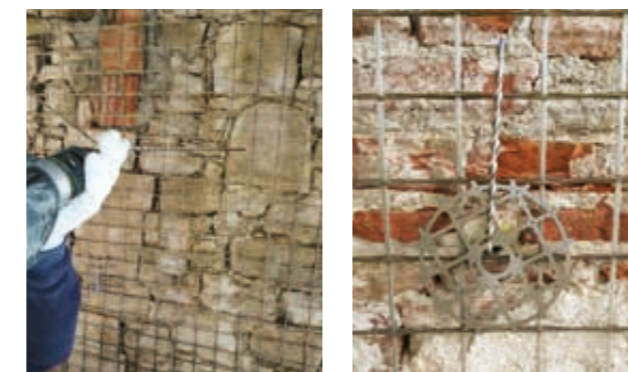
APPLICAZIONE DELLA RETE G-MESH
