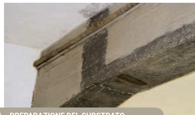
PREPARAZIONE DEL SUBSTRATO
