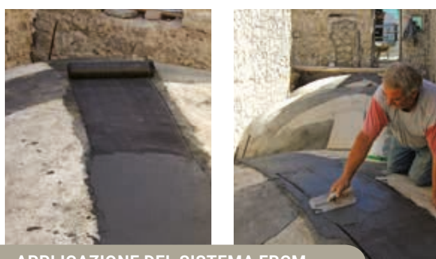
APPLICAZIONE DEL SISTEMA FRCM
