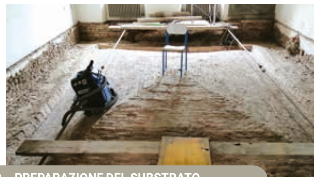
PREPARAZIONE DEL SUBSTRATO
