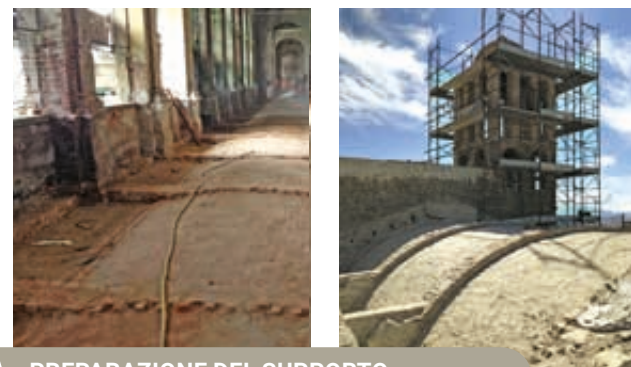
PREPARAZIONE DEL SUPPORTO
