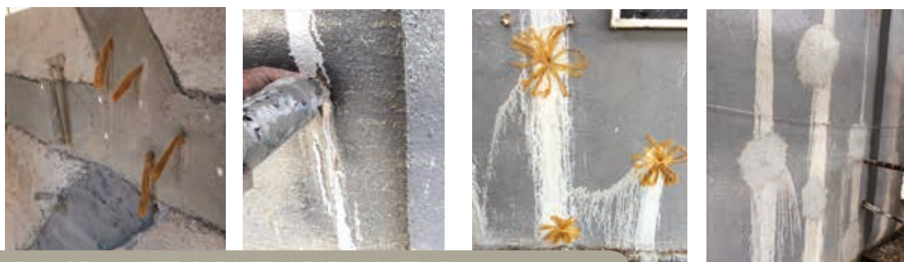
POSA DEI CONNETTORI E INIEZIONE DELLA MATRICE
