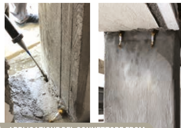
APPLICAZIONE DEL CONNETTORE FRM
