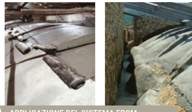
APPLICAZIONE DEL SISTEMA FRCM
