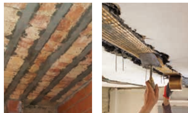
APPLICAZIONE DEL SISTEMA FRCM ALL'INTRADOSSO DEI TRAVETTI
