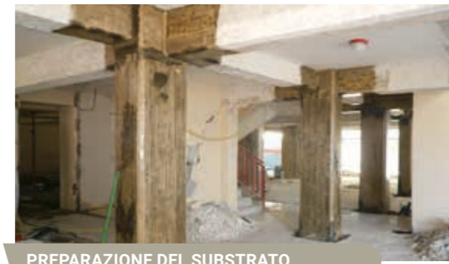
PREPARAZIONE DEL SUBSTRATO
