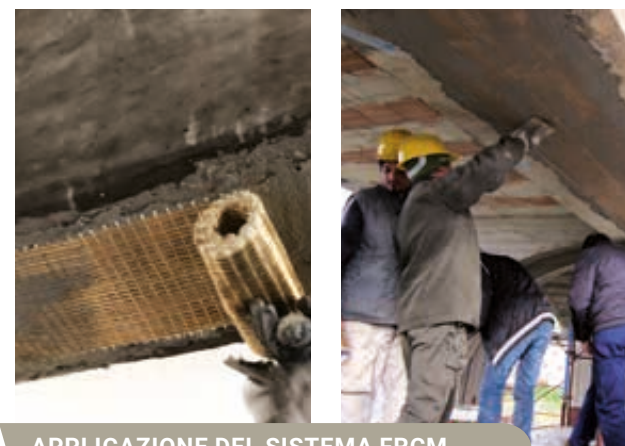
APPLICAZIONE DEL SISTEMA FRCM
