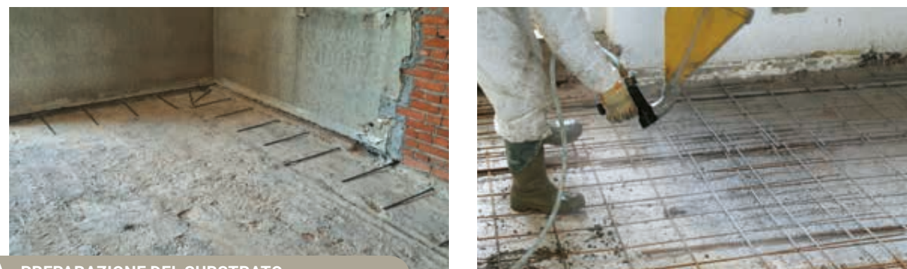
PREPARAZIONE DEL SUBSTRATO
