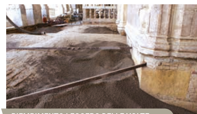
RIEMPIMENTO LEGGERO DELLE VOLTE
