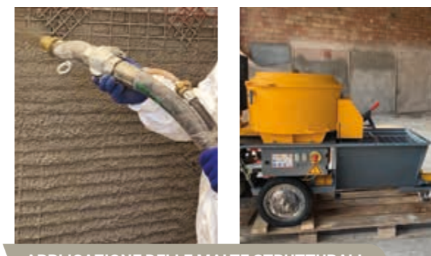
APPLICAZIONE DELLE MALTE STRUTTURALI
