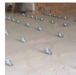
REALIZZAZIONE CAPPA DI CONSOLIDAMENTO IN CLS LEGGERO STRUTTURALE
