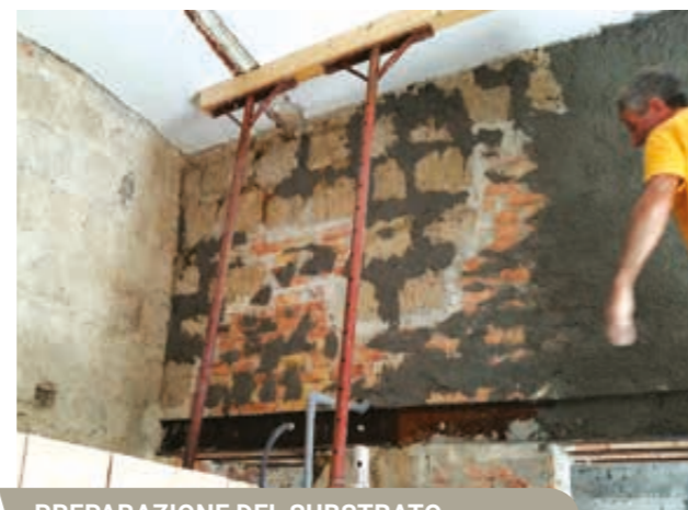
PREPARAZIONE DEL SUBSTRATO
