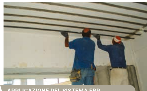
APPLICAZIONE DEL SISTEMA FRP
