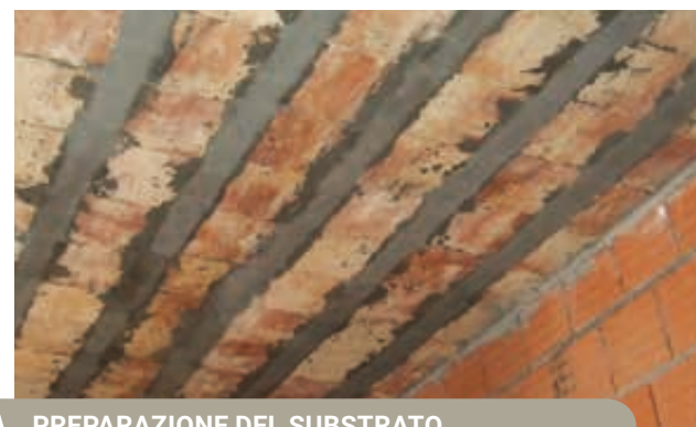
PREPARAZIONE DEL SUBSTRATO
