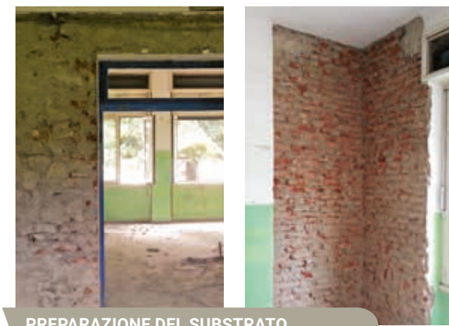
PREPARAZIONE DEL SUBSTRATO
