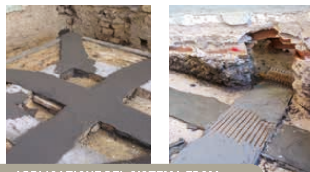
APPLICAZIONE DEL SISTEMA FRCM
