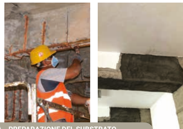
PREPARAZIONE DEL SUBSTRATO
