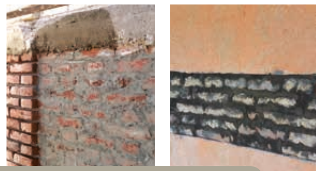
RISTILATURA DEI GIUNTI
