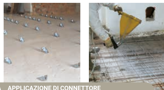
APPLICAZIONE DI CONNETTORE CENTROSTORICO ALL'ESTRADOSSO DEL SOLAIO
