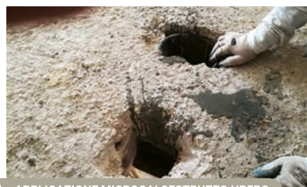
APPLICAZIONE MICROCALCESTRUZZO HPFRC
