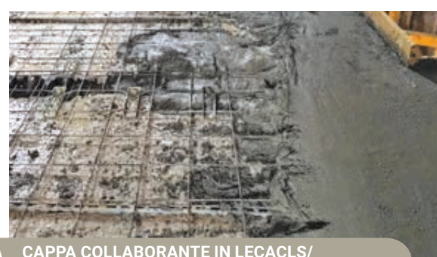
CAPPA COLLABORANTE IN LECACLS/CENTROSTORICO ALL'ESTRADOSSO DEL SOLAIO
