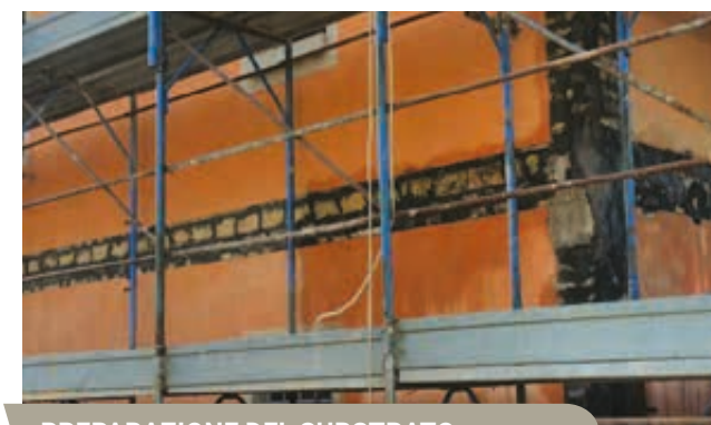
PREPARAZIONE DEL SUBSTRATO
