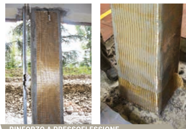
RINFORZO A PRESSOFLESSIONE, TAGLIO E CONFINAMENTO
