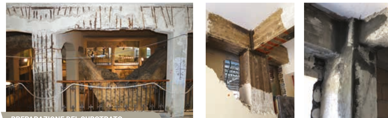
PREPARAZIONE DEL SUBSTRATO
