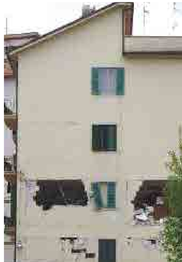
Pareti di tamponamento danneggiate in seguito al sisma de L'Aquila del 2009.
