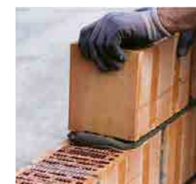
Posa del corso successivo di blocchi.
