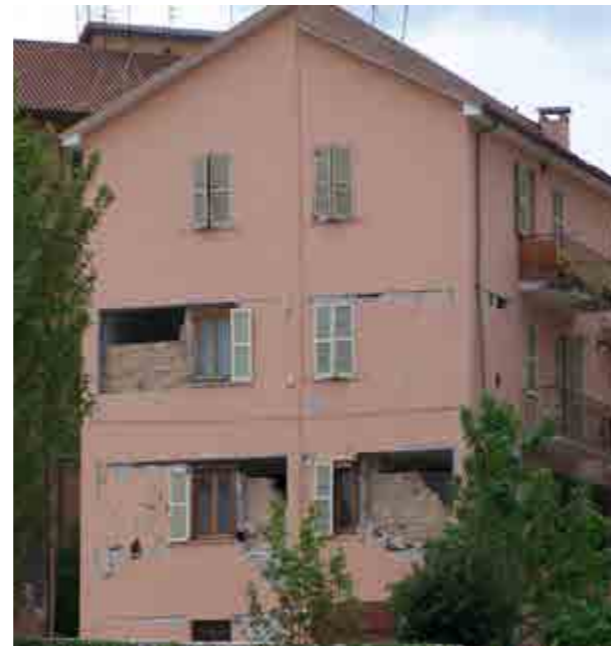
Pareti di tamponamento danneggiate in seguito al sisma de L'Aquila del 2009.
