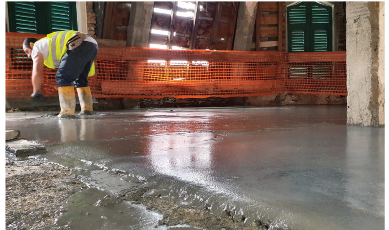
Staggiatura di Micro Gold Steel su solaio.
