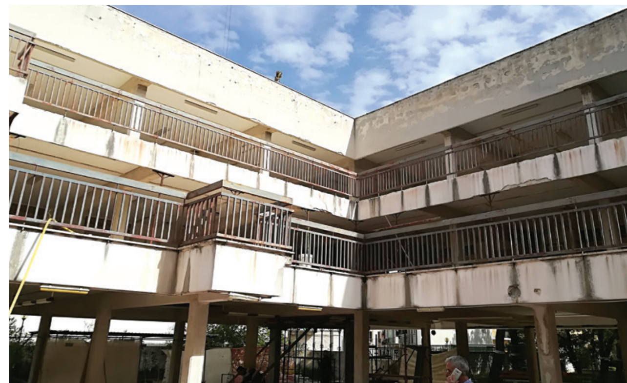
Incamiciatura telaio travi e pilastri in c.a. con Micro Gold Steel .
