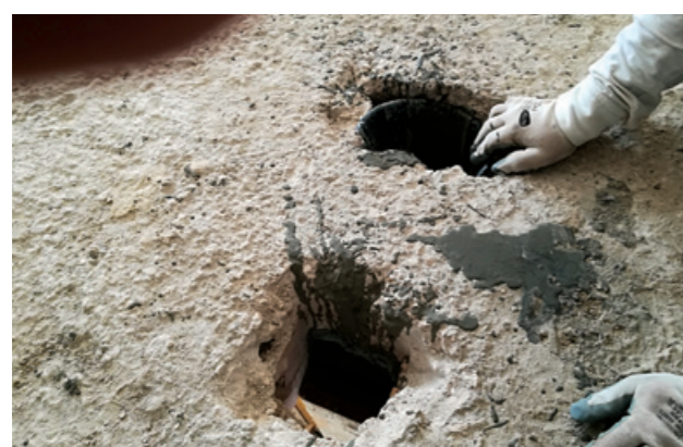
Applicazione su travi: inserimento dell'eventuale armatura longitudinale laddove il dimensionamento lo preveda. Getto di Micro Gold Steel partendo da un lato con flusso continuo.
