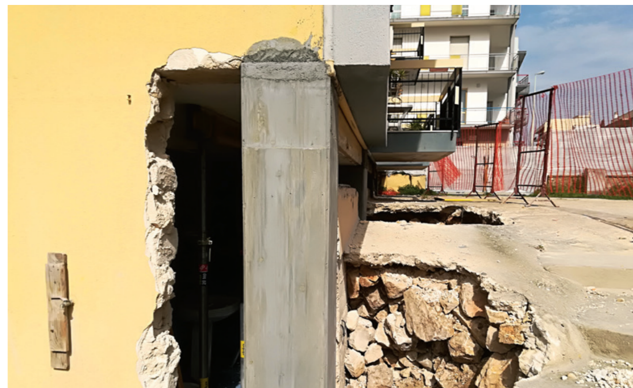
Incamicatura di travi e pilastri con Micro Gold Steel.
