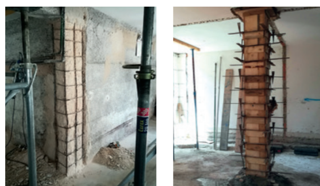
Preparazione del supporto: rimozione della ruggine dai ferri d'armatura mediante spazzolatura. Applicazione di Passivante Ruregold sui ferri d'armatura esistenti.
