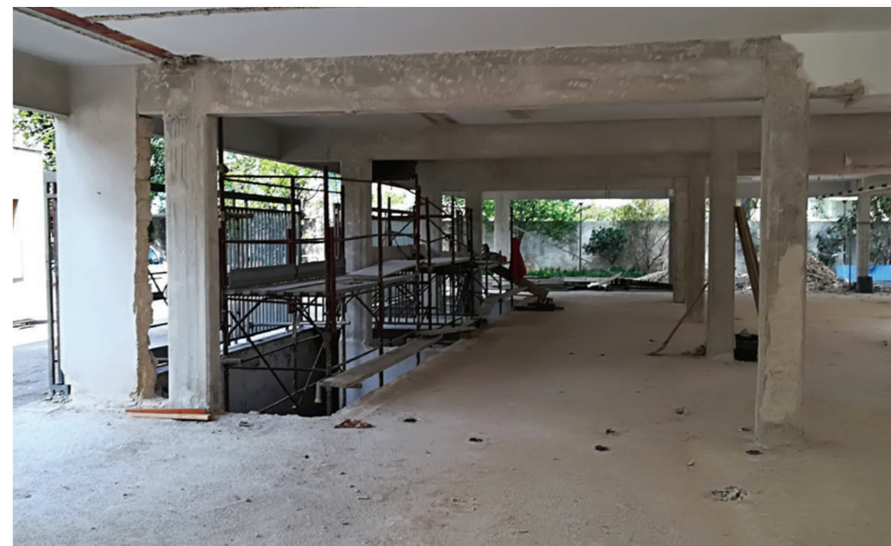
Preparazione del substrato: asportazione dell'eventuale strato ammalorato, rimozione della ruggine dai ferri d'armatura e applicazione del Passivante Ruregold sui ferri di armatura esistenti.
