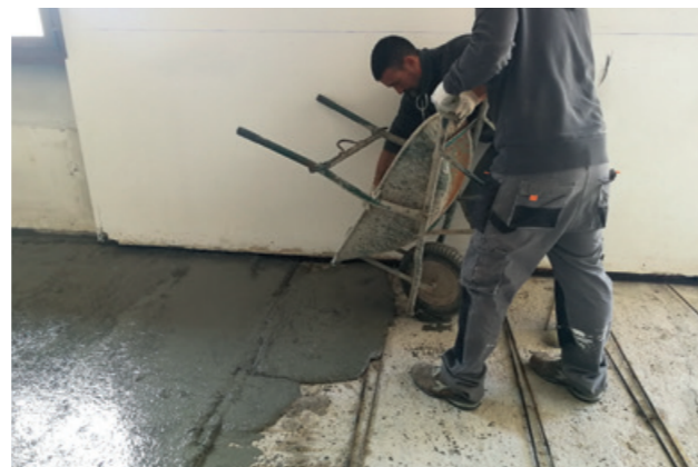
Formazione del sistema di connessione perimetrale mediante barre ad aderenza migliorata o Connettore Elicoidale di Ruregold. Posa di Micro Gold Steel sulla superficie e successiva staggiatura a livello.
