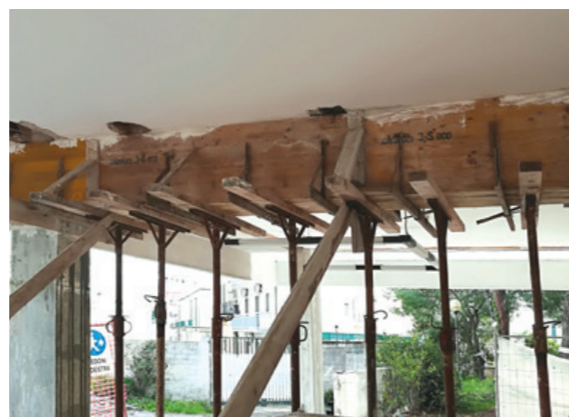
Predisposizione di un cassero a perfetta tenuta per effettuare il getto di Micro Gold Steel mediante colatura.
