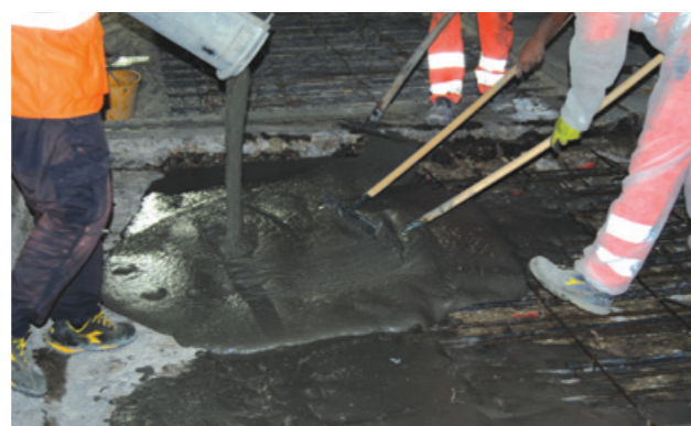
Ripristino estradossale della soletta in c.a. con microcalcestruzzo fibrorinforzato Micro Gold Steel .
