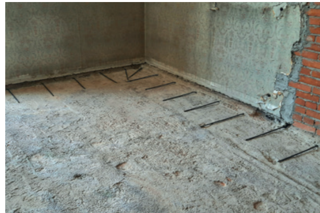
Il sottofondo deve essere solido, fortemente ruvido con scabrezza pari a 5 mm oppure prevedere l'utilizzo di adesivo epossidico Connettore Centrostorico Chimico .
