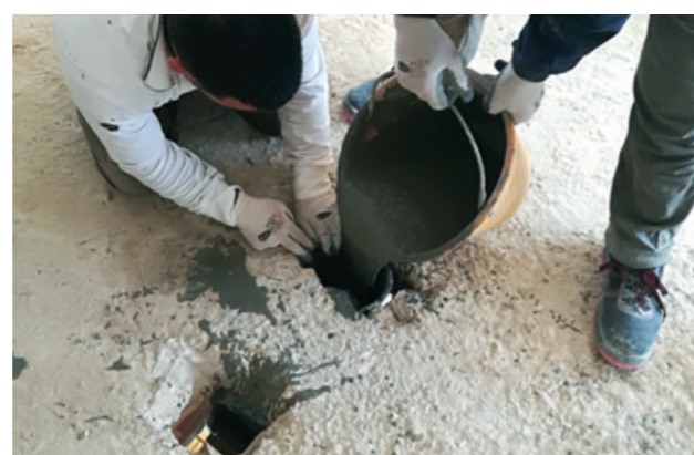
Colatura di Micro Gold Steel attraverso la tasca-foro su trave.
