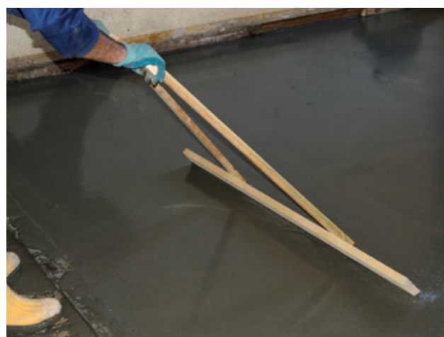
Posa in opera di Micro Gold Steel e livellamento nello spessore di progetto.
