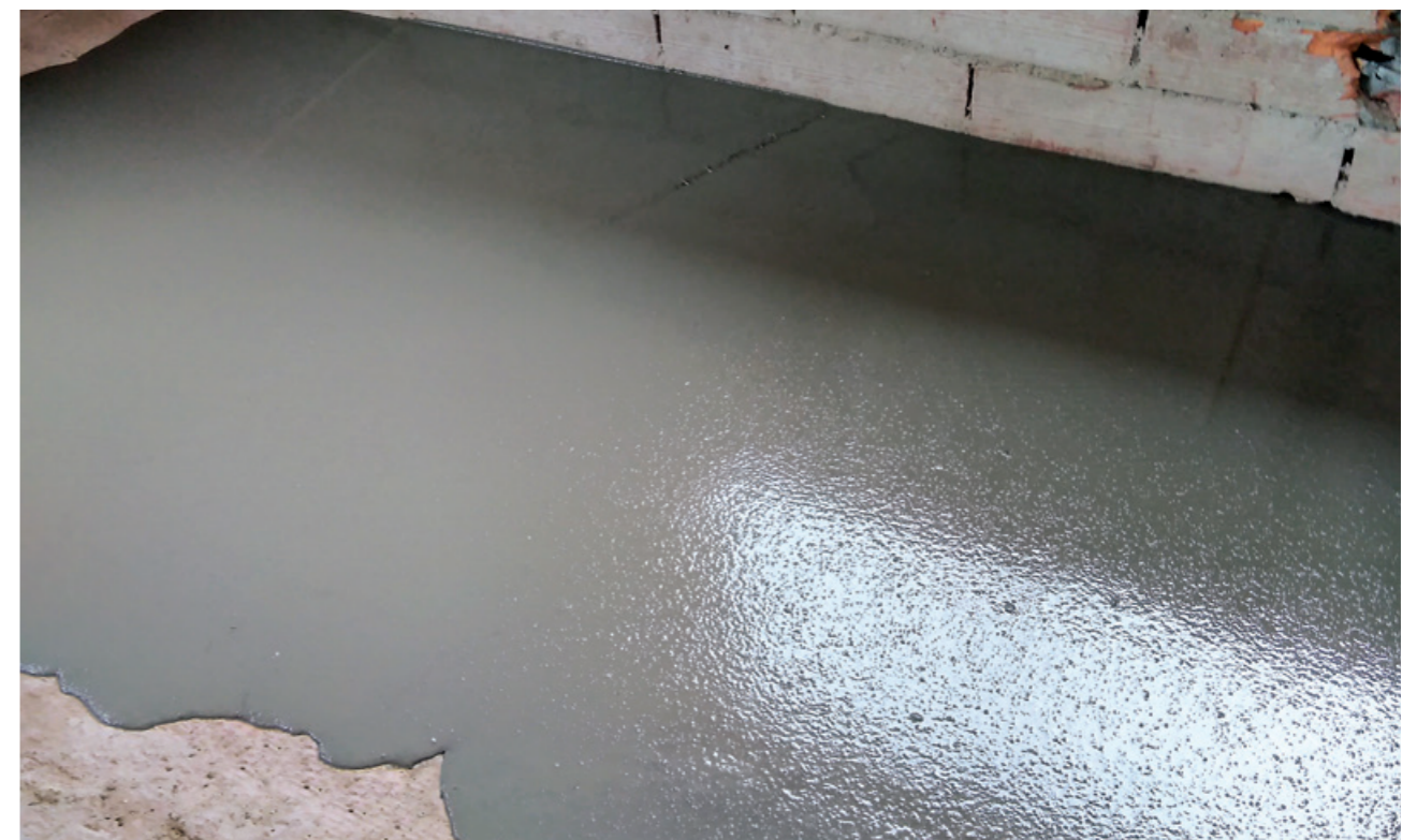
Consolidamento statico in basso spessore di solaio con Micro Gold Steel .
