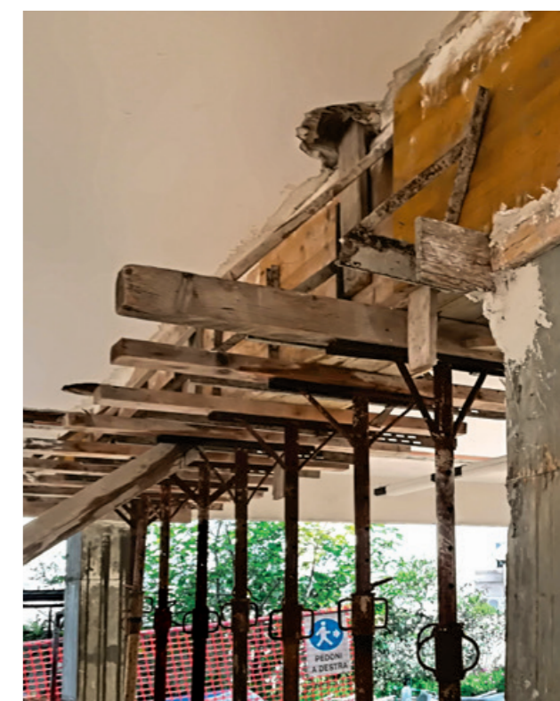
Predisposizione del cassero per il getto di Micro Gold Steel .
