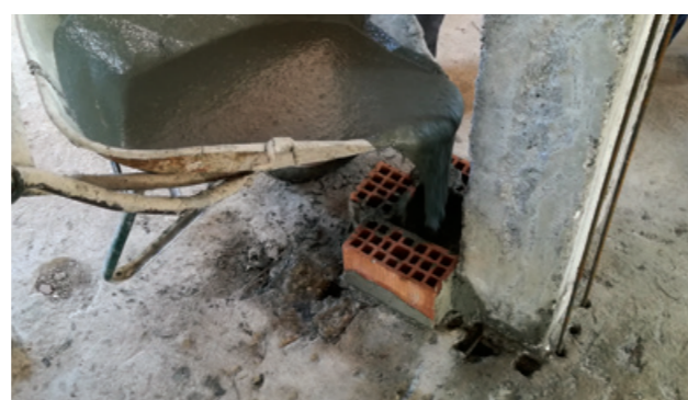
Applicazione su pilastri: cassero a tenuta con raddoppio di cravatte e sigillatura al piede. Inizio del getto di Micro Gold Steel di Ruregold partendo da un lato con flusso continuo.
