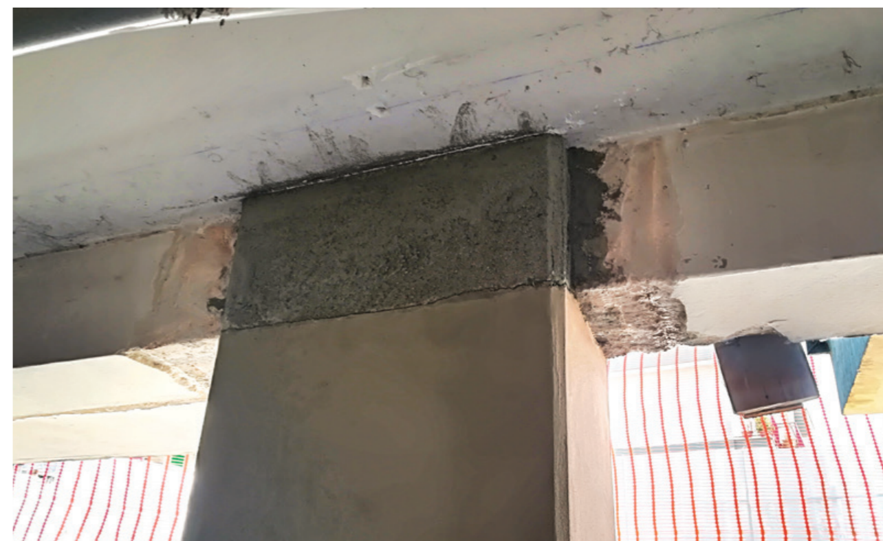
Pannello di nodo trave-pilastro rinforzato con Micro Gold Steel di Ruregold
