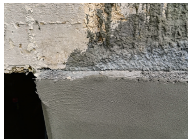
Particolare di pannello di nodo trave-pilastro rinforzato con Micro Gold Steel .
