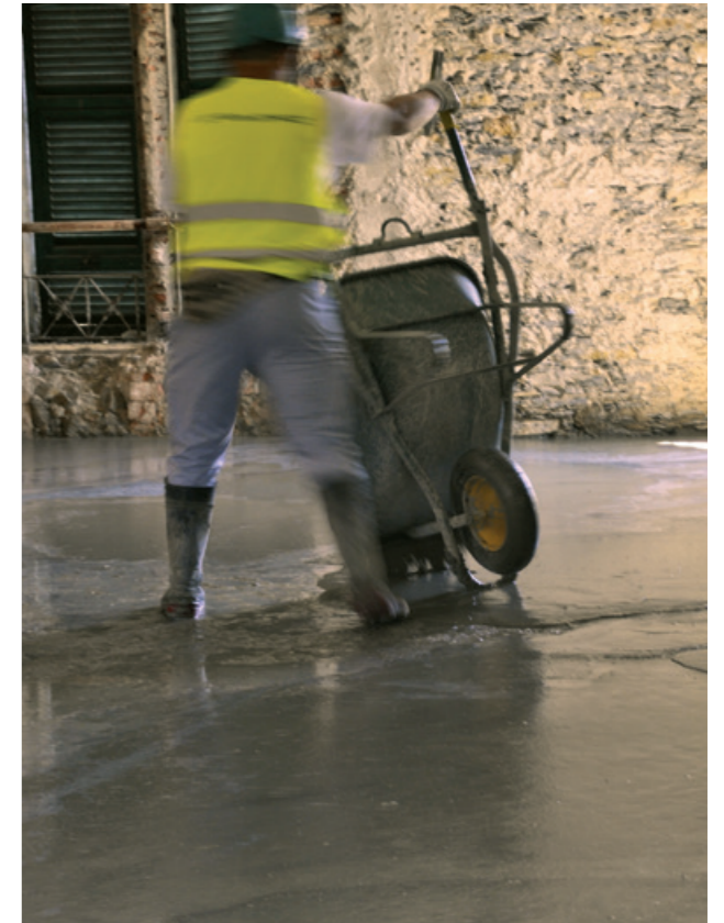
Rinforzo di solaio a basso spessore con Micro Gold Steel .
