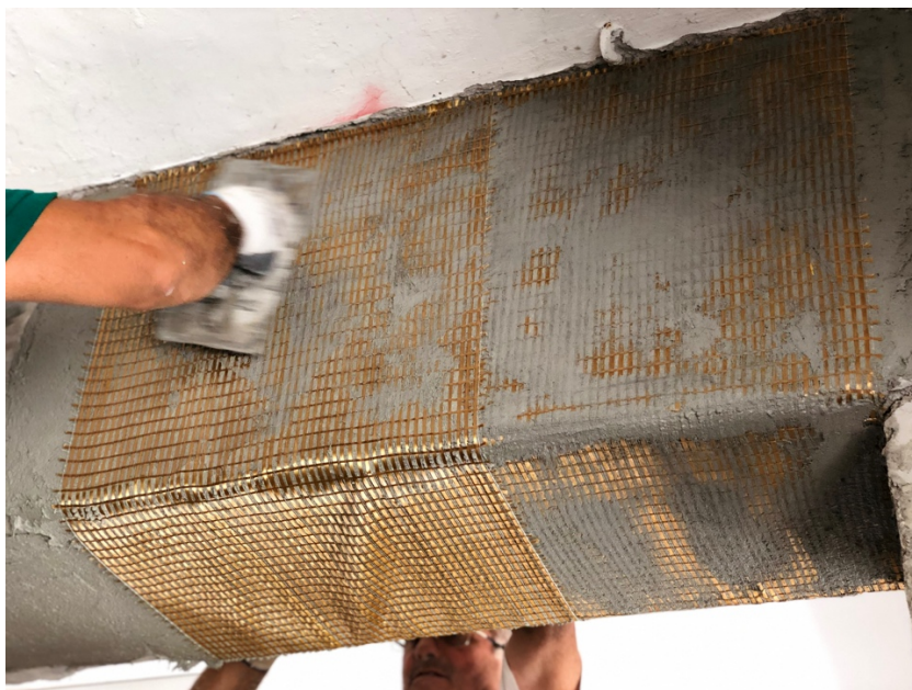
Fig. 8 – Esempio di rinforzo con materiale FRCM durante la messa in opera
