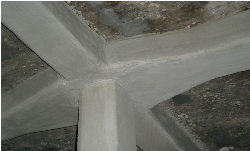
Fig. 34 – Confinamento estremità travi e pilastro mediante FRCM
