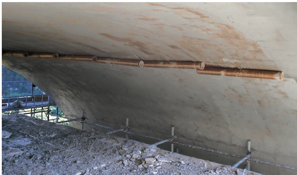
Fig. 49 – Rinforzo di una struttura ad arco con FRCM
