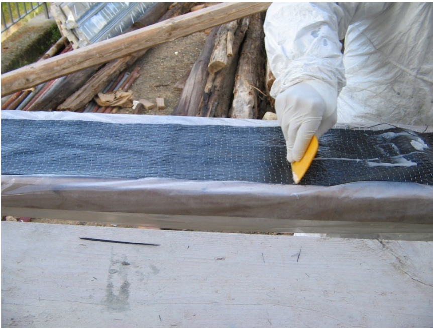
Fig. 6 – Esempio di rinforzo con materiale FRP durante la fase di preparazione
