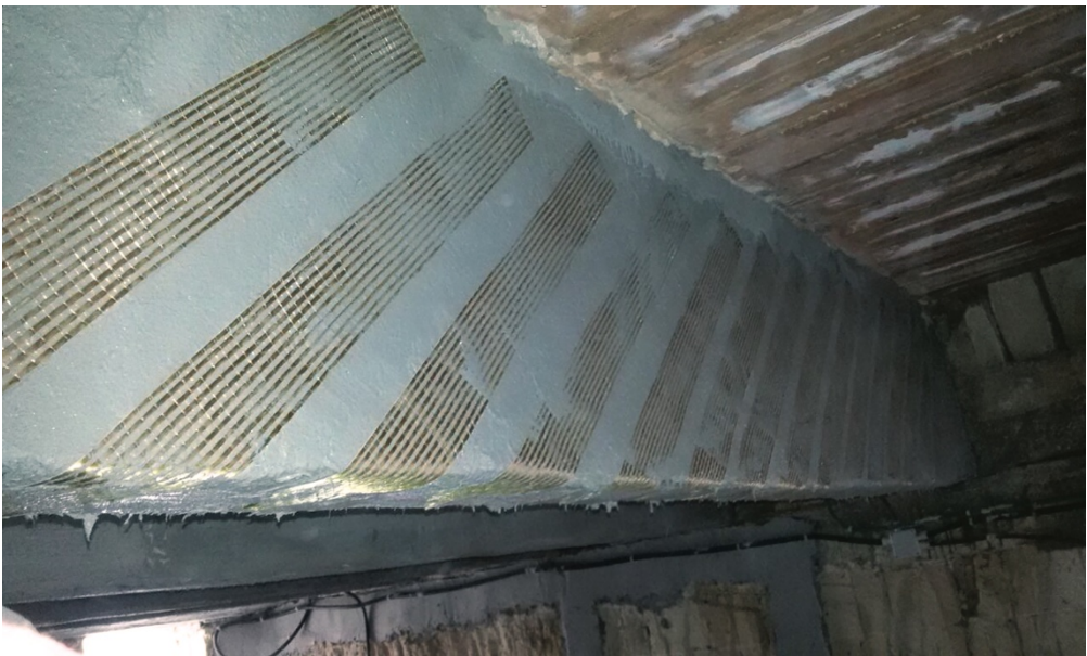
Fig. 33 – Applicazione FRCM per rinforzo a taglio di trave in c.a.
