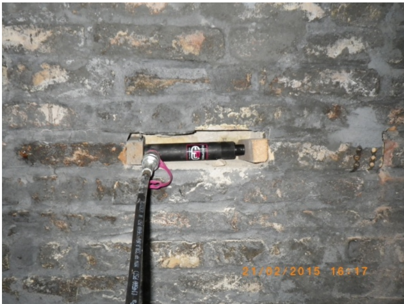
Fig. 15 – Esempio di “shear test” secondo la ASTM C1531 su parete ristilata
