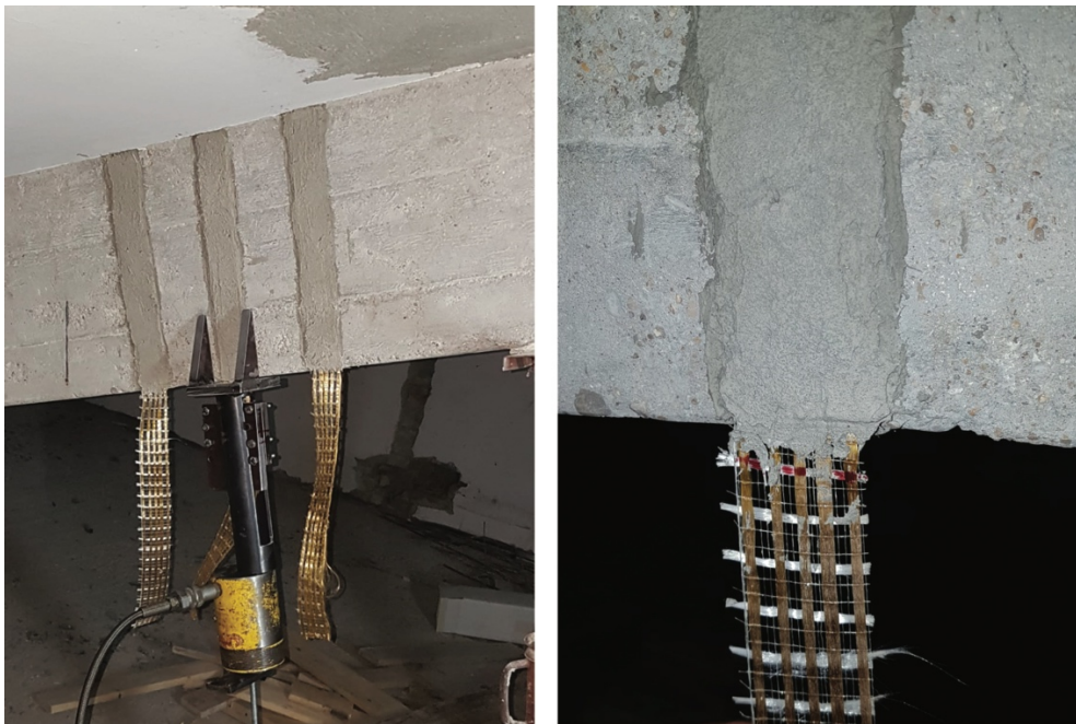
Fig. 19, 20 – Prove di delaminazione in sito di un rinforzo FRCM con fibre di PBO
