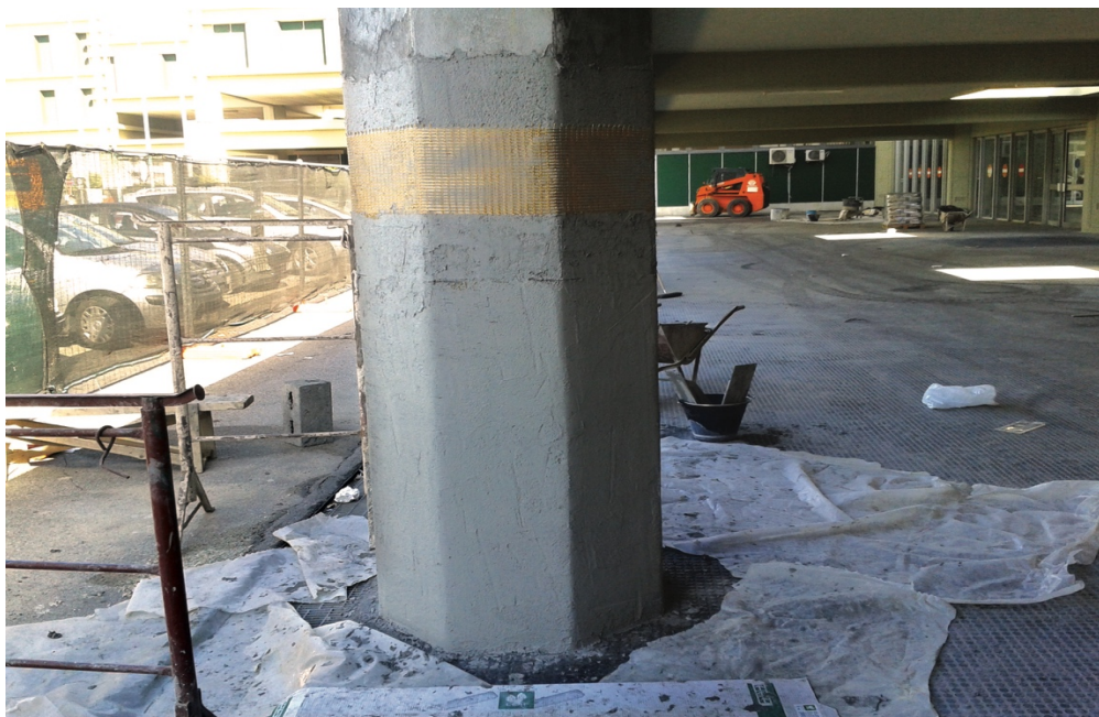
Fig. 35 – Confinamento pilastro mediante FRCM
