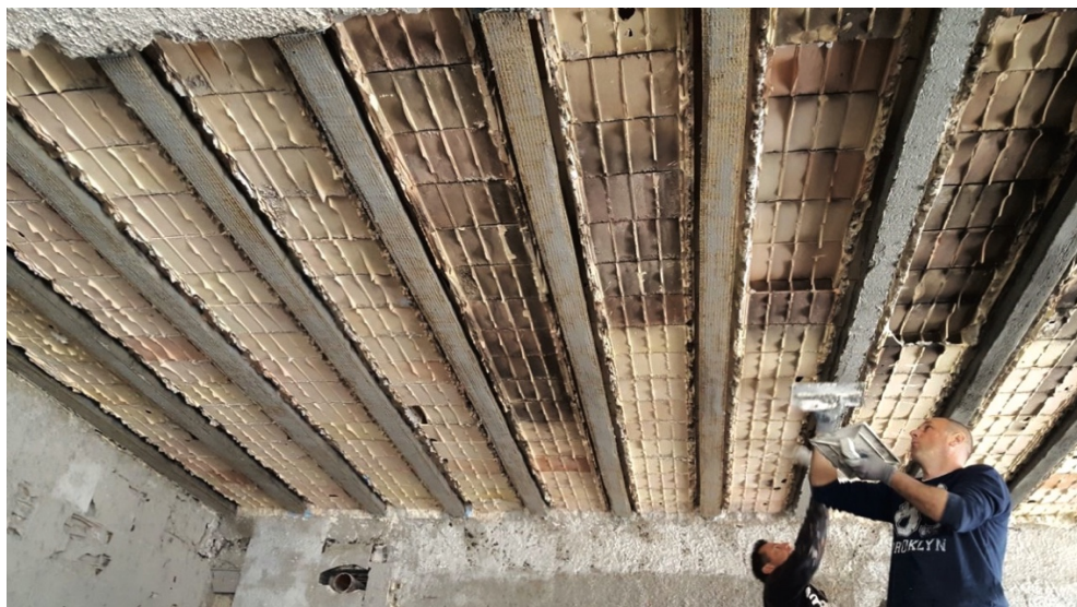
Fig. 30 – Applicazione FRCM in PBO per rinforzo a flessione di travetti in c.a.
