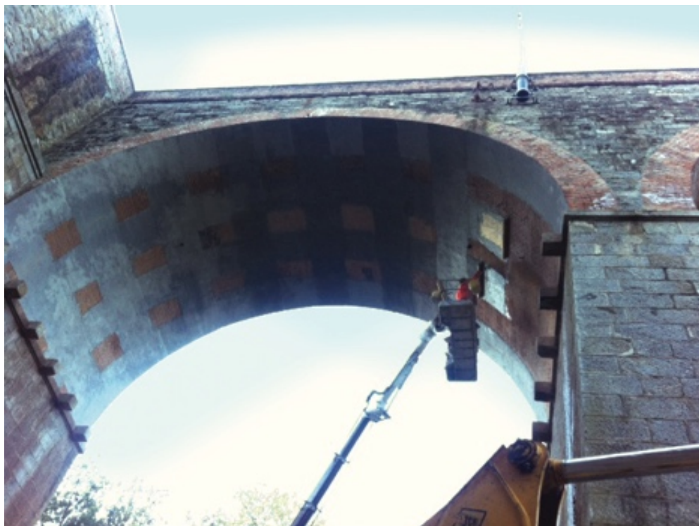
Fig. 48 – Rinforzo ponte ad arco in muratura con FRCM
