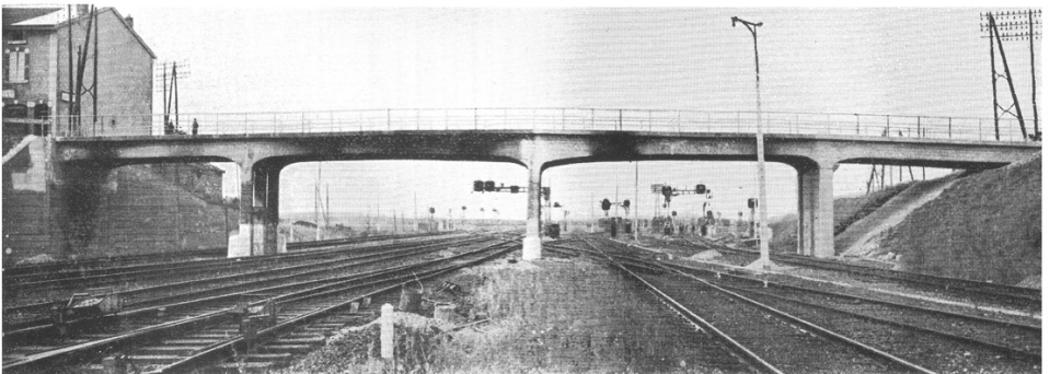
Fig. 3 – Fasi della ricostruzione di un ponte in c.a. parzialmente distrutto
