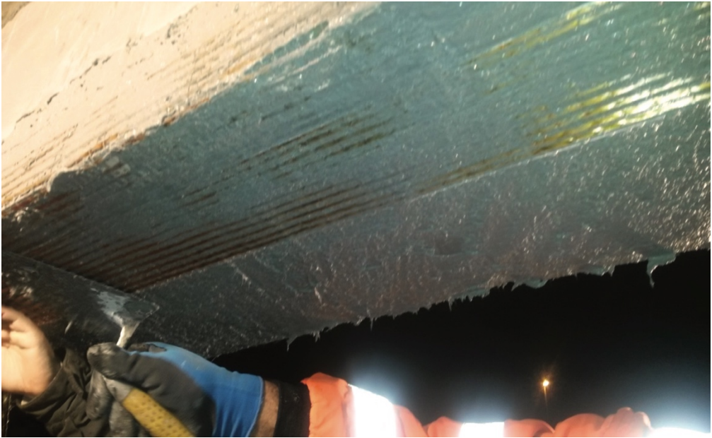
Fig. 32 – Applicazione FRCM in PBO per rinforzo a flessione di trave in c.a.
