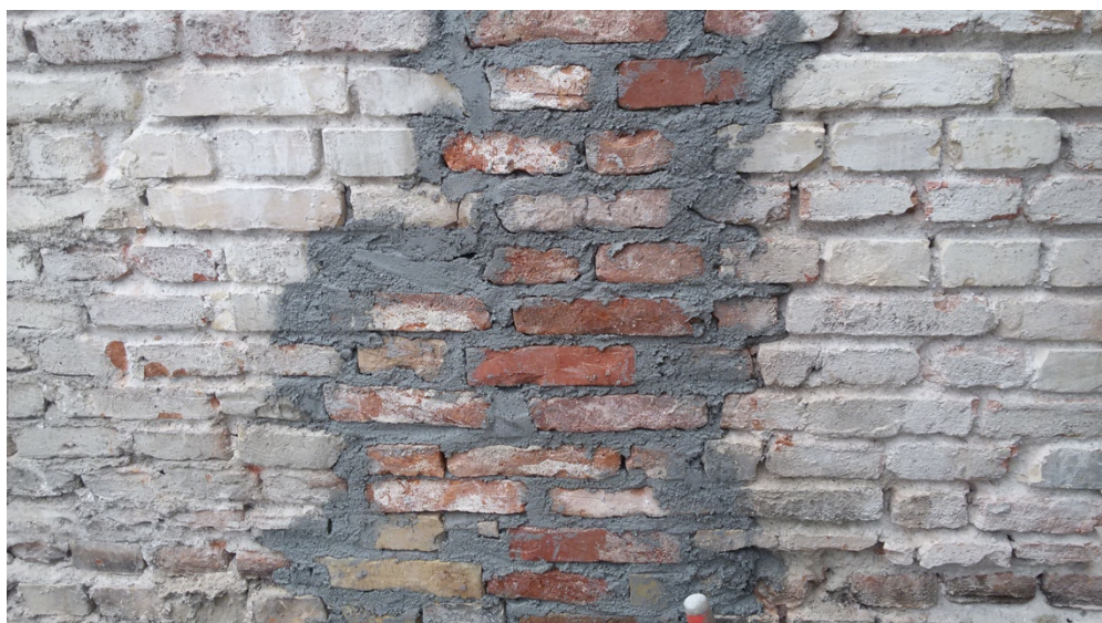
Fig. 2 – Ricucitura muraria dopo la rimozione di una canna fumaria
