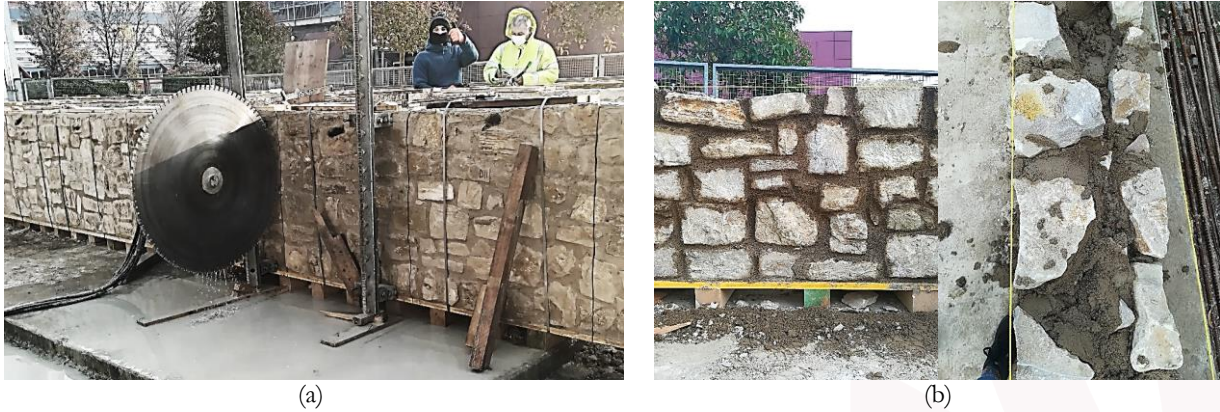
Figura 1: Paredi in muratura: (a) operazioni di taglio; (b) tessitura della muratura durante la costruzione.
