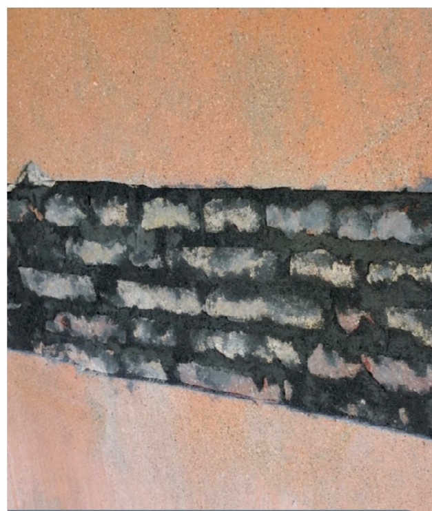
Particolare stilatura muratura con malta strutturale MX-PVA.
