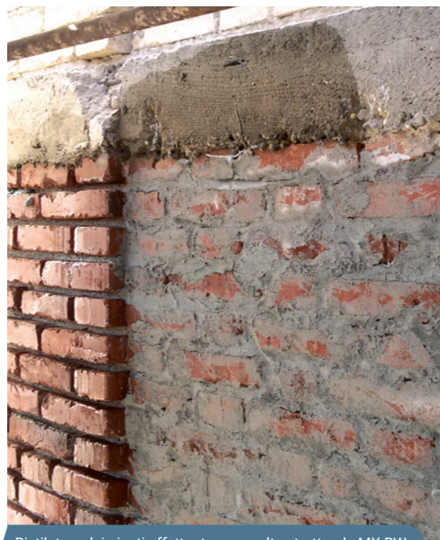
Ristilatura dei giunti effettuata con malta strutturale MX-RW.
