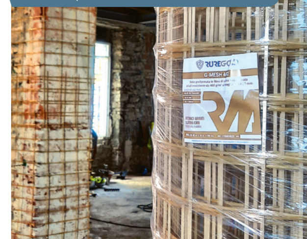
Sistema CRM, con rete in fibra di vetro e malte strutturali.
