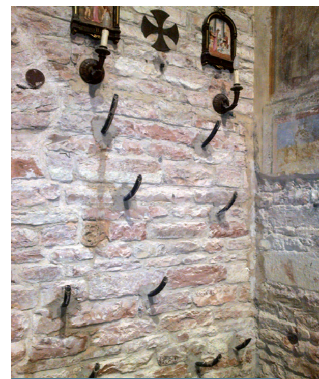
Intervento di iniezioni con MX-INJECT su una struttura in muratura.
