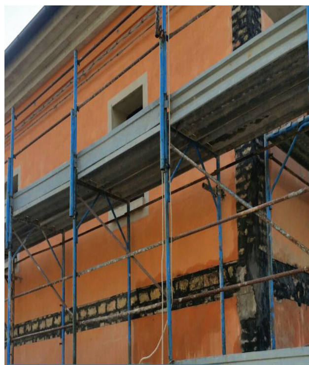
Stilatura con malta strutturale MX-PVA.
