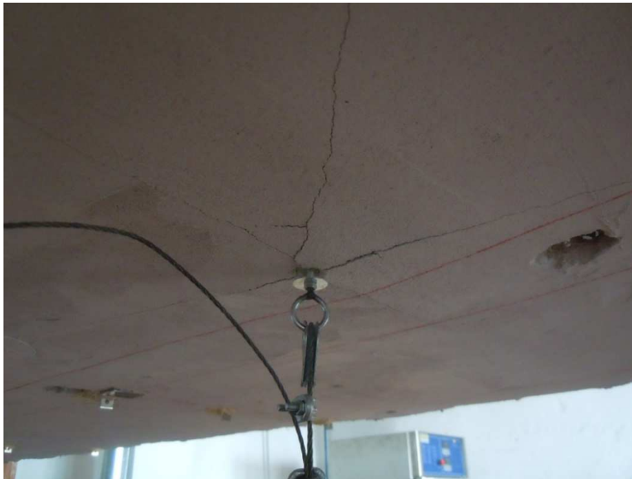
Foto n. 3.10 – Inizio fase di sfilamento del tassello 3 e innesco stato fessurativo
