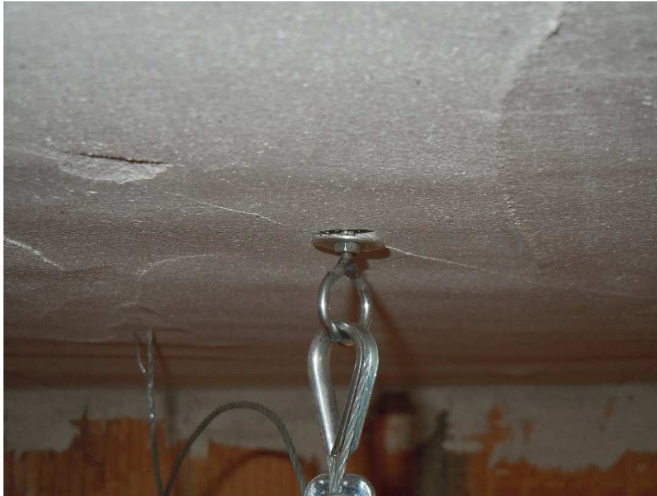
Foto n. 3.2 – Inizio fase di sfilamento del tassello 1 e innesco stato fessurativo
