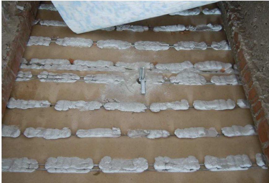
Foto n. 3.12 – Posizione tassello RIF
