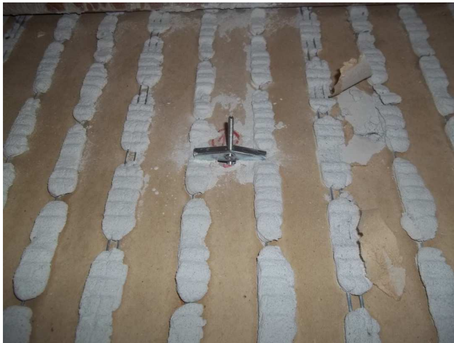
Foto n. 4 – Modalità di posa in opera del tassello ad “ancora” nella prova “pilota”
