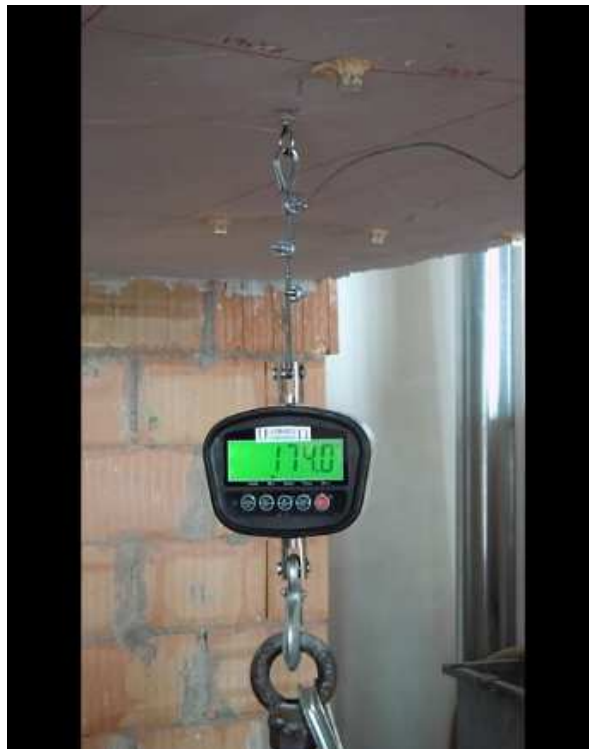
Foto n. 3.13 – Indicazione della forza massima, espressa in kgf, in fase di rottura (tassello RIF)
