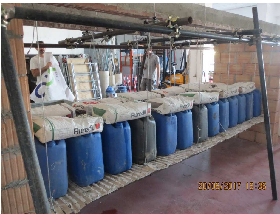
Foto n. 6 – Applicazione del carico massimo di prova sul pannello Stucanet®
