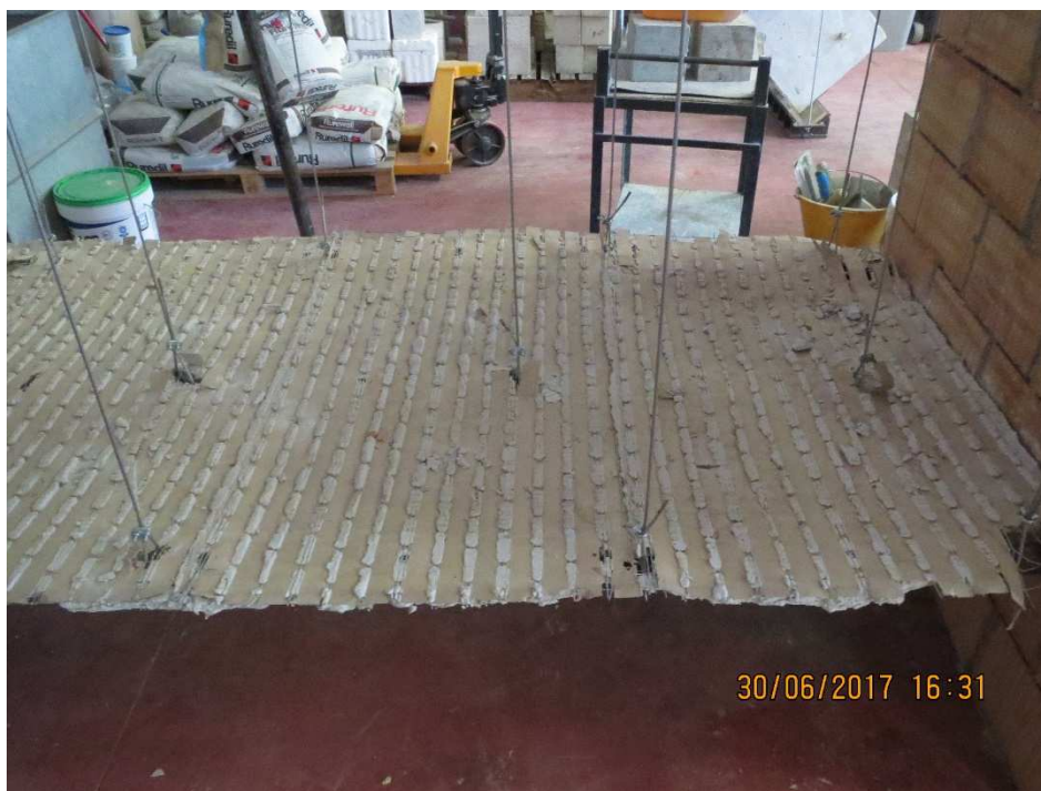
Foto n. 2 – Dettaglio del pannello Stucanet ® appeso ai travetti
