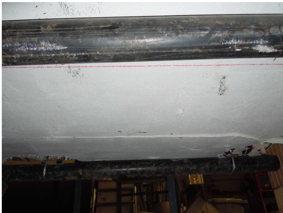
Foto n. 3 – Sistema di sospensione del pannello con cavi di acciaio e tubi “Innocenti” posti all’intradosso del pannello stesso
