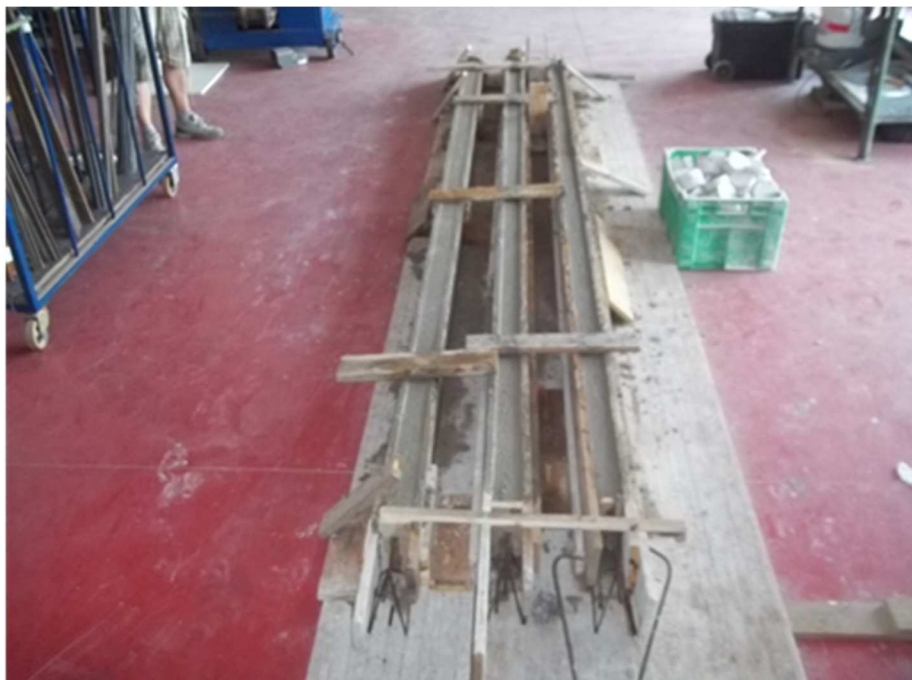
Foto n. 2.1.1 – Fase costruttiva dei travetti del solaio
