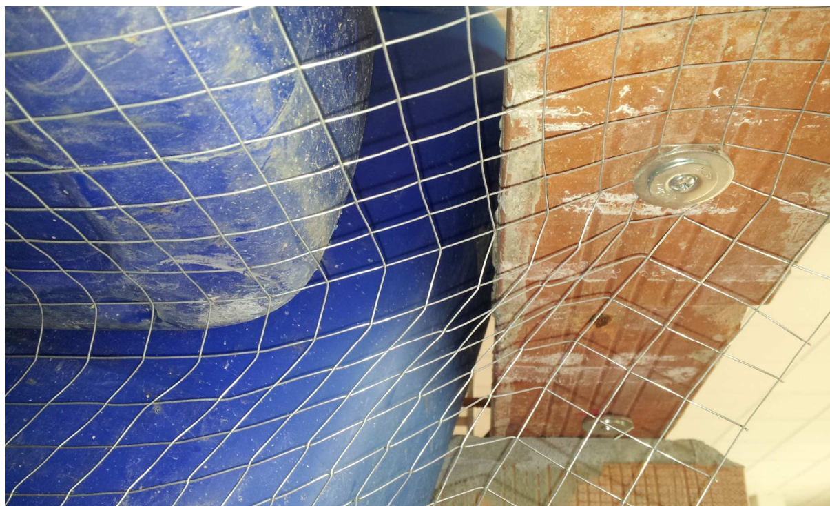
Foto n. 2.2.1.9 – Deformazione della rete sotto carico in corrispondenza di un travetto laterale
