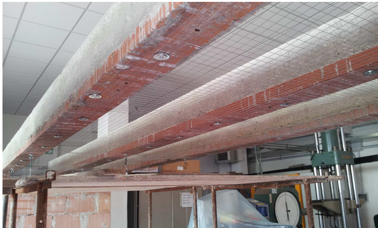
Foto n. 2.2.1.1 – Applicazione della rete Armanet®-R all'intradosso dei travetti
