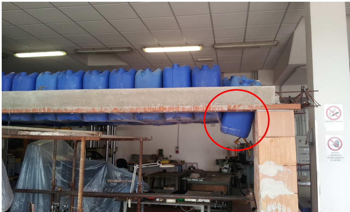
Foto n. 2.2.1.7 – Raggiungimento della crisi locale del “sistema”
