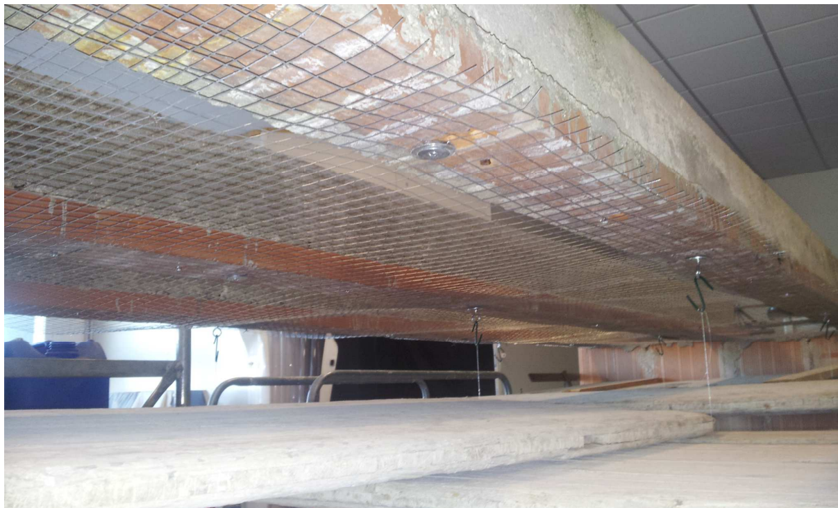
Foto n. 2.2.2.1 – Applicazione della rete
