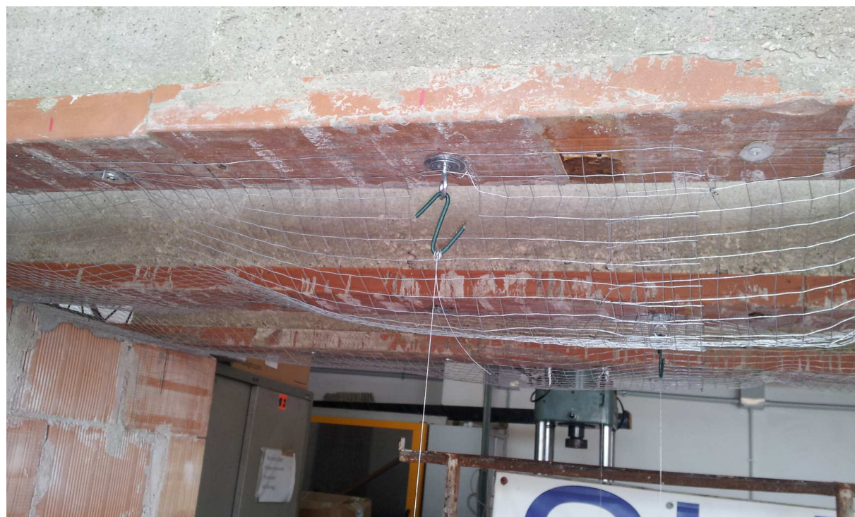
Foto n. 2.2.1.12 – Deformazione residua della rete dopo rimozione della zavorra
