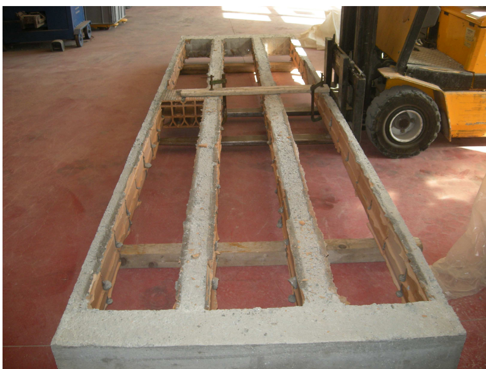
Foto n. 2.1.6 – Conclusione della demolizione delle “volterrane”
