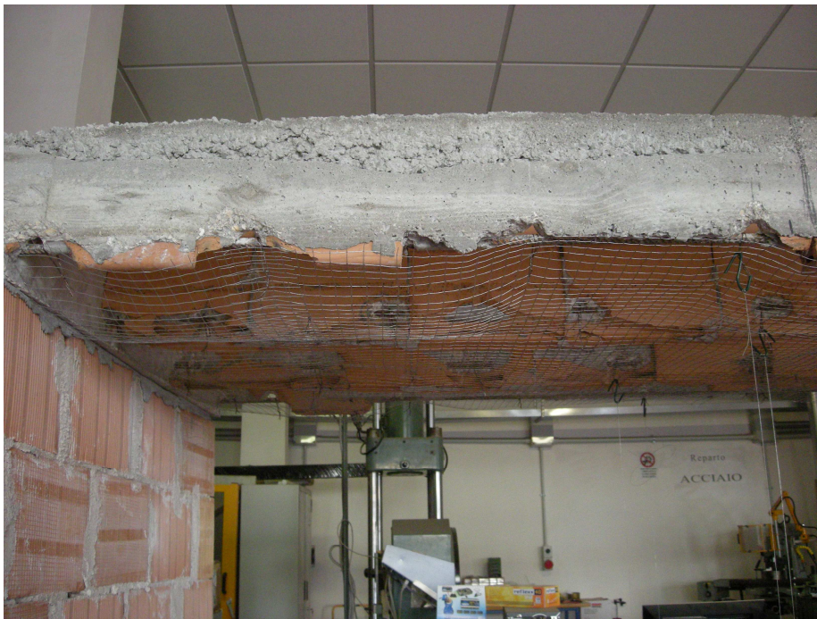
Foto n. 2.2.1.2 – Applicazione della rete Armanet®-R all'intradosso delle nervature del solaio
