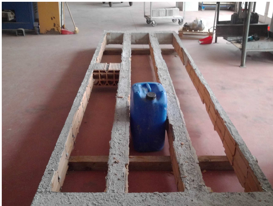
Foto n. 2.1.7 – Verifica dimensionale della zavorra
