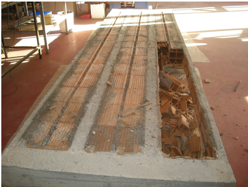
Foto n. 2.1.5 – Inizio della fase di demolizione delle “volterrane”
