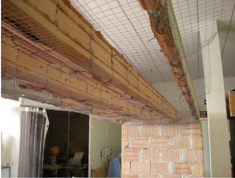
Foto n. 2.2.1.1 – Applicazione della rete Armanet®-R all'intradosso delle nervature del solaio
