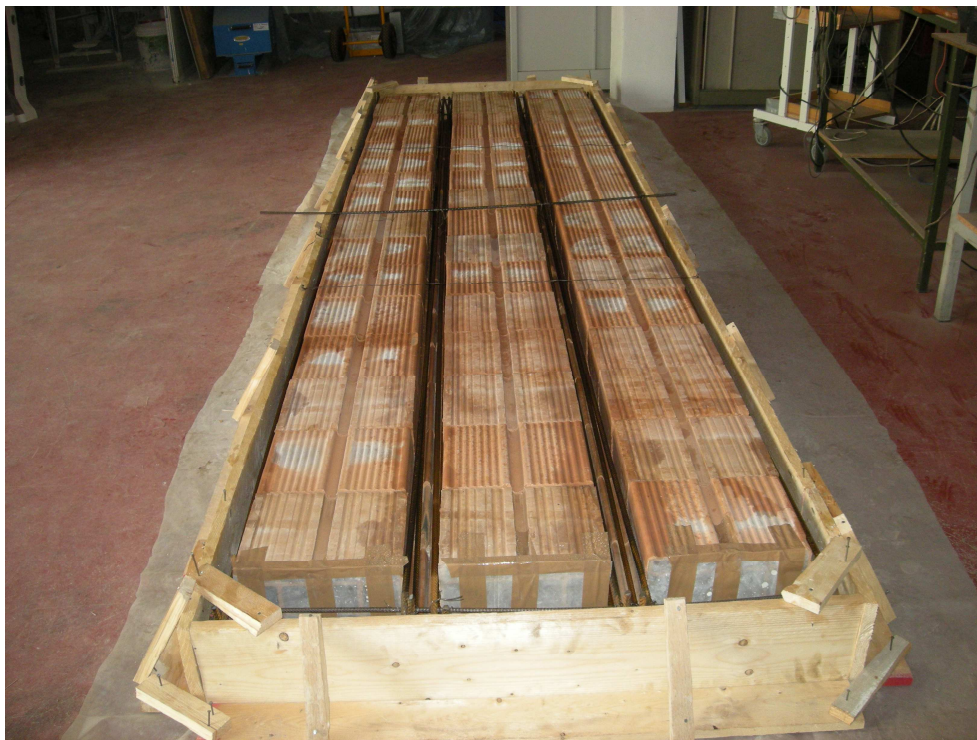
Foto n. 2.1.1 – Fase costruttiva delle nervature del solaio prima del getto di calcestruzzo
