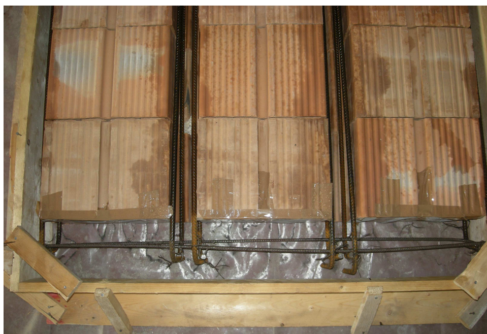
Foto n. 2.1.2 – Fase costruttiva, alle estremità del solaio, del cordolo di appoggio del solaio sulle due pareti in laterizio forato
