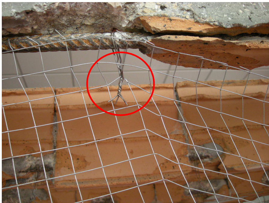
Foto n. 2.2.1.8 – Deformazione delle maglie della rete per effetto del fissaggio
