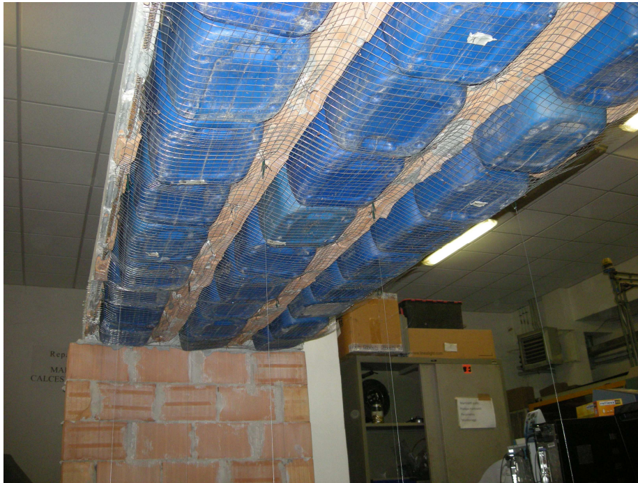
Foto n. 2.2.1.7 – Deformazione della rete sotto carico
