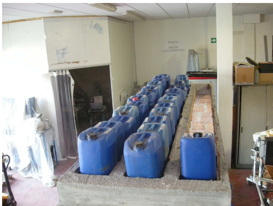
Foto n. 2.2.2.2 – Vista dall’alto della zona collassata
