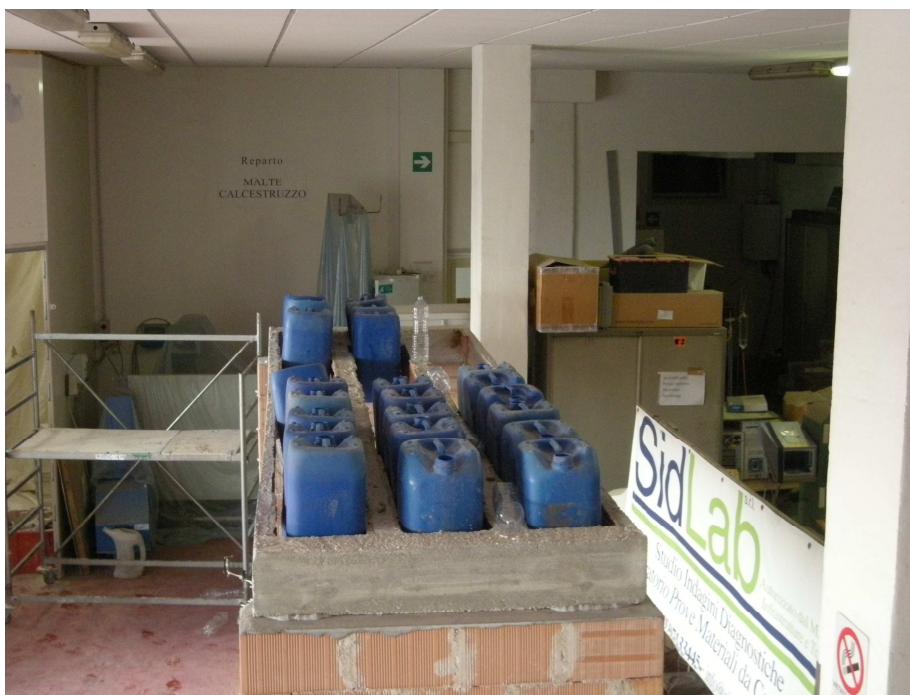
Foto n. 2.2.1.12 – Vista dall’alto della zona collassata
