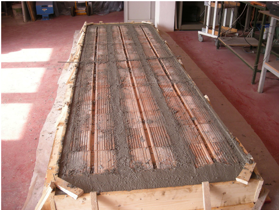
Foto n. 2.1.4 – Getto del solaio completato, privo di soletta collaborante
