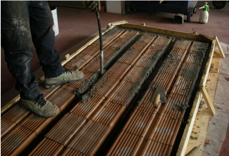
Foto n. 2.1.3 – Fase di getto delle nervature con passaggio del vibratore
