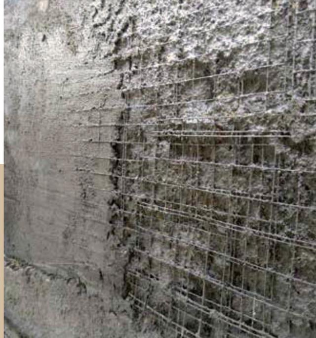
**STUCANET SN** es una malla electrosoldada de alta galvanización o inoxidable, adecuada para restaurar estructuras de mampostería (ladrillo, piedra, toba, etc.) con los morteros MX-RW Elevadas Prestaciones y MX-CP Cal.
