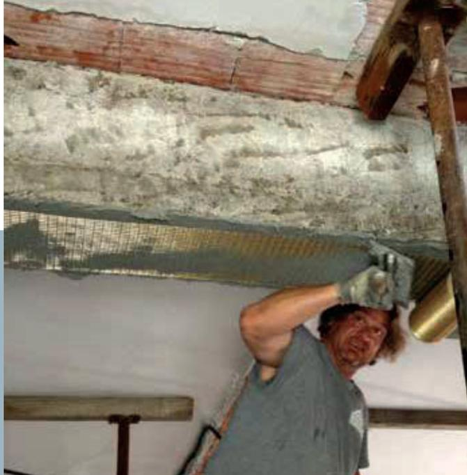
**PBO-MESH 88** es un sistema de refuerzo estructural FRCM con tejido PBO unidireccional y matriz inorgánica estabilizada para construcciones de hormigón armado y mampostería. El alto gramaje de PBO lo hace adecuado para aplicaciones importantes en hormigón y mampostería como envolturas o refuerzos al cortante y flexión.
