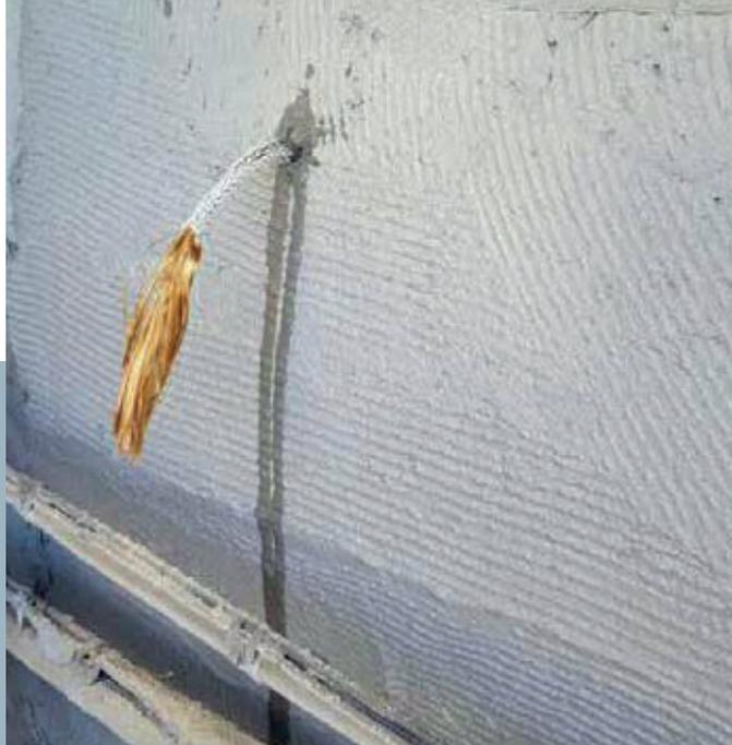
**PBO-JOINT** es un sistema de conexión en fibras unidireccionales en PBO para la construcción del anclaje entre las estructuras existentes y los sistemas de refuerzo estructural en PBO de tipo FRCCM.
