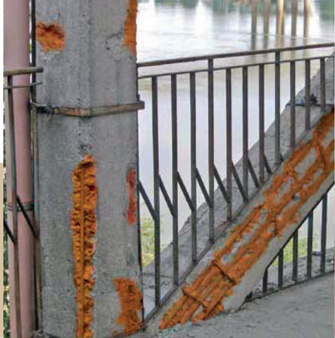
**Pasivate** es un mortero monocomponente de color rojizo basado en aglutinantes cementosos, resinas sintéticas, microsílíce y aditivos especiales que inhiben la corrosión.
