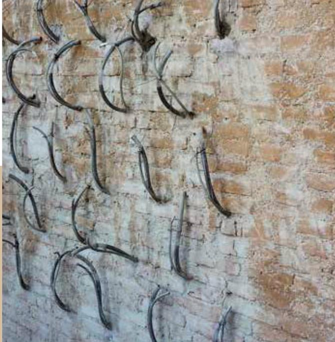
**MX INJECT** es un ligante hidráulico puzolánico con bajo contenido de sal que, mezclado con agua, permite la producción de lechadas de inyección compatibles con los materiales de construcción de las paredes preexistentes.
