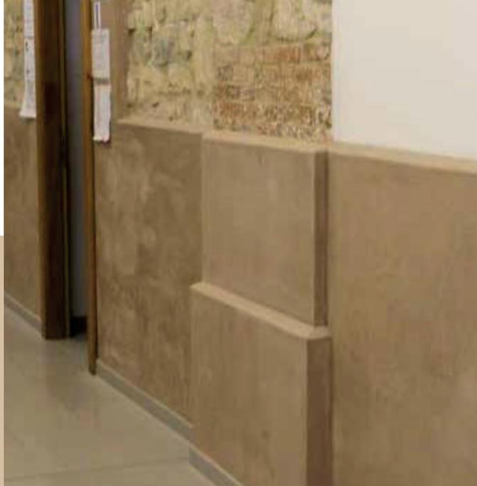
**MX-CP Cal** es una premezcla basada en cal hidráulica natural pura NHL 3.5 para la restauración de paredes, transpirable y compatible con cualquier soporte de pared. Después de agregar agua, se obtiene un mortero altamente adhesivo a la mampostería, toba y piedras, duradero y adecuado para reparaciones y revoques estructurales.
