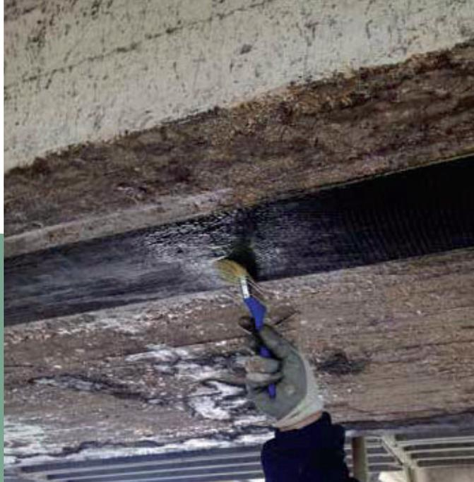
**C-WRAP** es un sistema de conexión en fibras de carbono unidireccionales para la construcción de sistemas de refuerzo estructural de tipo FRP.
