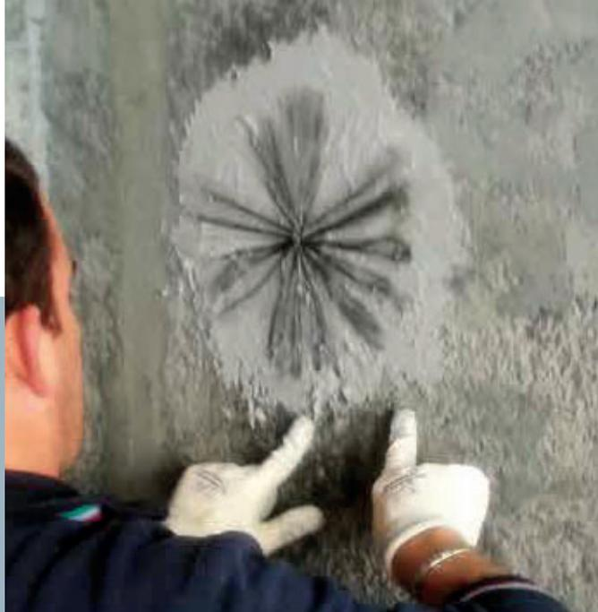
**C-JOINT** es un sistema de conexión en fibras de carbono unidireccionales para la construcción del anclaje entre las estructuras existentes y los sistemas de refuerzo estructural en carbono de tipo FRCM.
